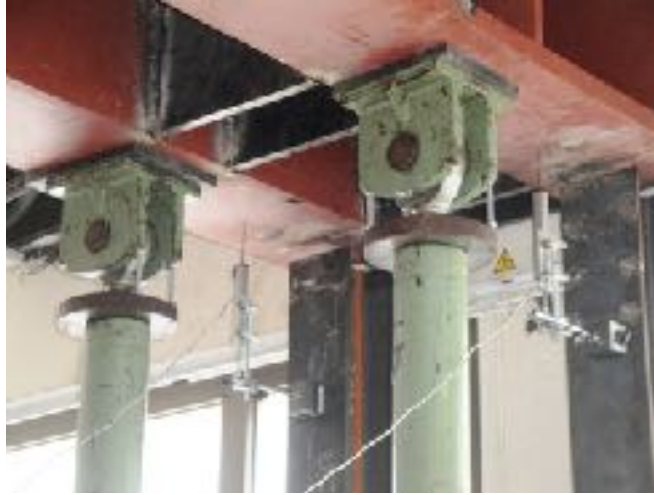
Gats hidràulics i transductors de desplaçament, amb les bigues ja separades dels pilars
