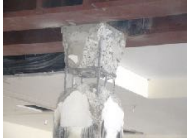
Repicat del formigó dels pilars fins a deixar l'armadura nua
