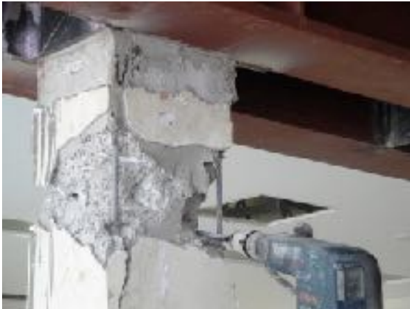
Repicat del formigó dels pilars fins a deixar l'armadura nua
