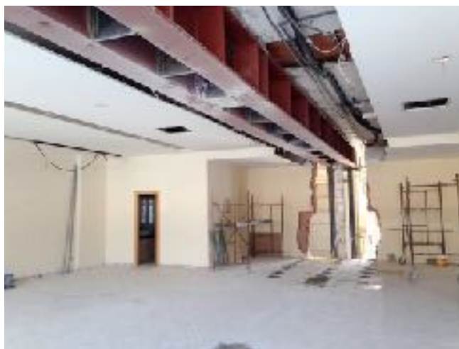
Vista general després de l'actuació
