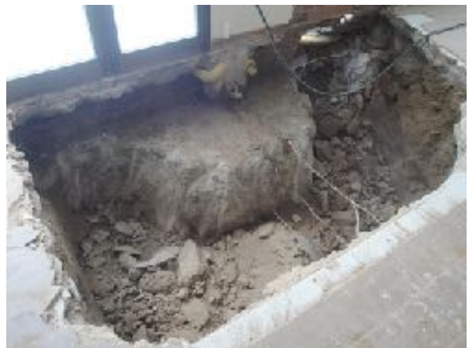
Nova sabata pel fonament P01 i ampliació del fonament P04
