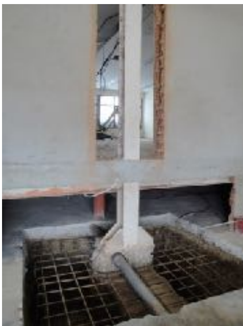
Nova sabata pel fonament P01 i ampliació del fonament P04
