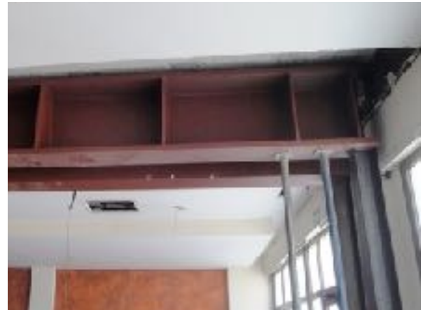
Recolzament provisional de les bigues sobre els nous pilars metàl·lics (P01) i (P04)
