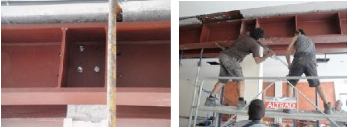
Procés de fixació de les bigues als pilars de formigó P02 i P03 a suprimir
