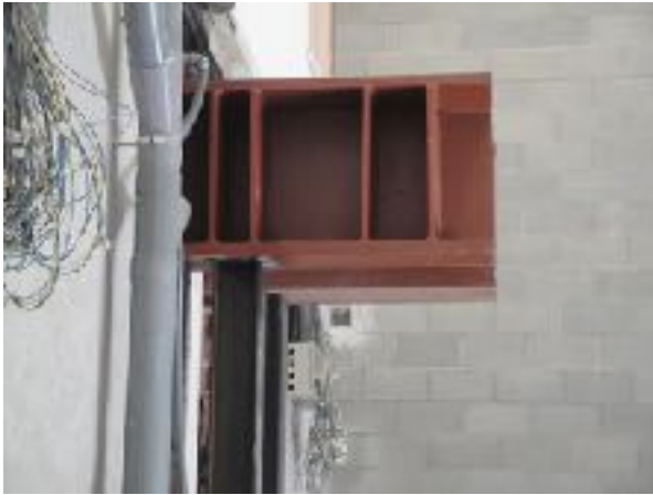
Recolzament provisional de les bigues sobre els nous pilars metàl·lics (P01) i (P04)
