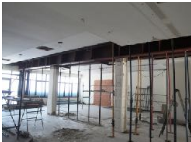
Vista general de la col·locació de bigues i pilars metàl·lics
