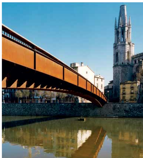
Pont sobre l'Onyar a Girona. Amb 55 m de llum, forma i materials que aconsegueixen una integració molt adient amb l'entorn. Foto: Jordi S. Carrera.
