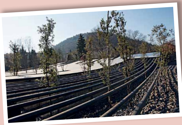
Pavelló Les Cols. Projecte molt singular per tenir una estructura de cables amb coberta i parets translúcides i completament integrada en l'entorn. Foto: A. Blázquez.
