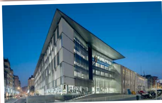
Edifici Generalitat Girona. Projecte de gran envergadura que contempla la rehabilitació d'un edifici del segle XVII, una nova construcció d'oficines i un aparcament soterrat de 170 m de longitud sense junts de dilatació. Foto: Duccio Malagamba.
