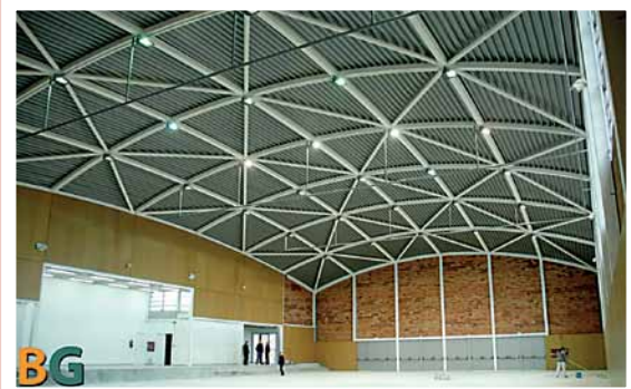
Pavelló de Bordils. Estructura amb coberta en forma de volta bufada, seguint les geometries proposades per l'arquitecte Ignasi Bosch, famós per les seves voltes de ceràmica. Aconsegueix salvar llums de 45 \times 30 \text{ m}^2 amb una sola capa de perfils de 20 cm de cantell. Foto: A. Blázquez.
