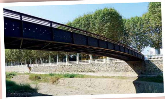
Pont de La Bisbal. Amb 40 m de llum, una evolució cap a la senzillesa del pont de Girona, construït amb molt pocs recursos. Foto: A. Blázquez.
