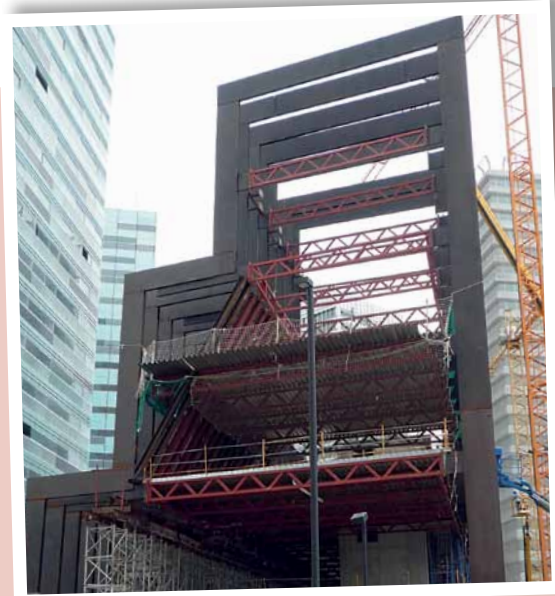
Seu Layetana. Edifici d'estructura metàl·lica amb els suports estructurals fora de l'envolent de l'edifici i de gran esveltesa. Foto: A. Blázquez.
