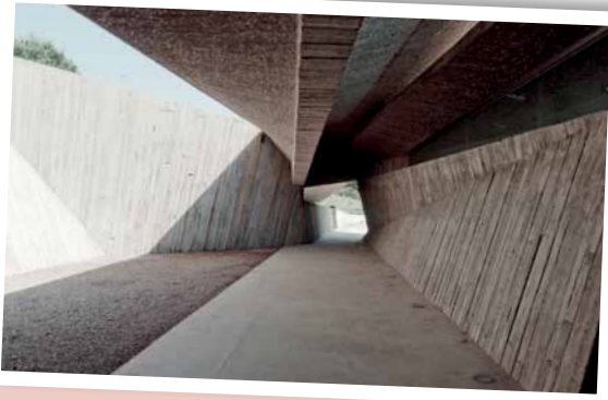
Accés a les ruïnes d'Empúries. Edifici de formigó amb volumetria molt complexa, perquè quasi tots els elements estructurals estan inclinats i són de gruixos variables, amb acabats vistos i rugosos. Foto: Marc Torra.
